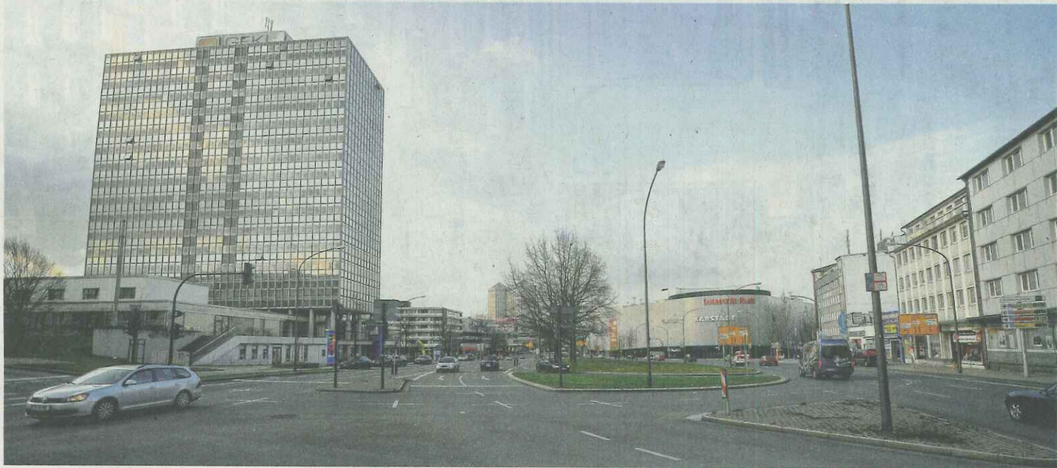
Bald ein Leerstand: Generalmieter GFKL zieht im Juni aus dem Hochhaus am Limbecker Platz. Die 13 Etagen seien unpraktisch, der Sanierungsstau zu groß. FOTO: BAUER
